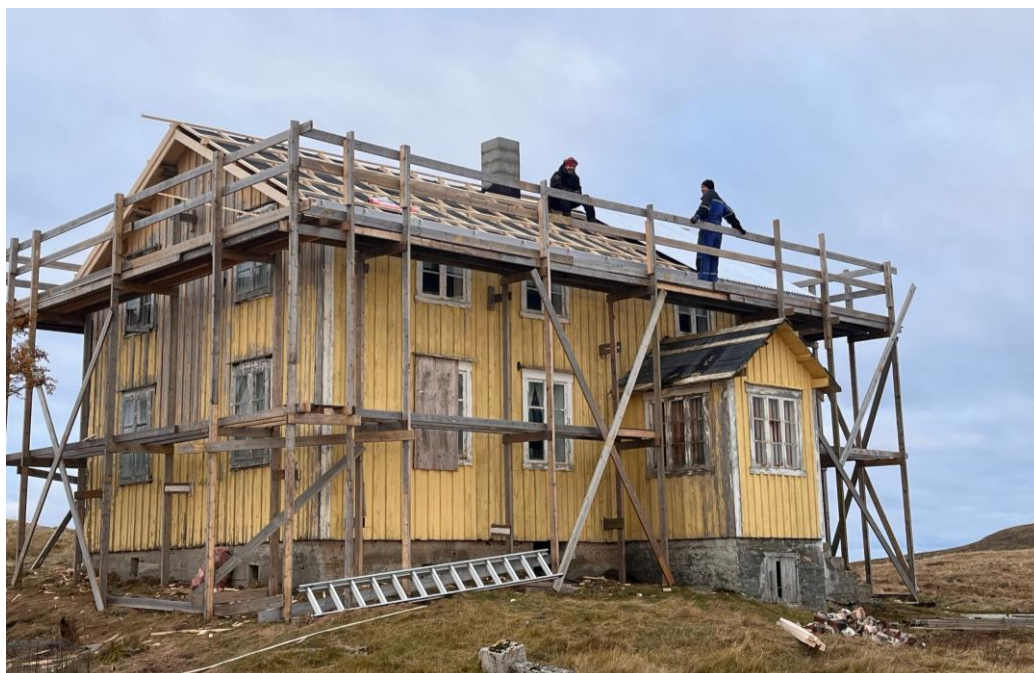
TAKET PÅ HOVEDHUSET PÅ GANGARØY BLE SKIFTET HØSTEN 2023 OG KAIA BLE UTBEDRET.
